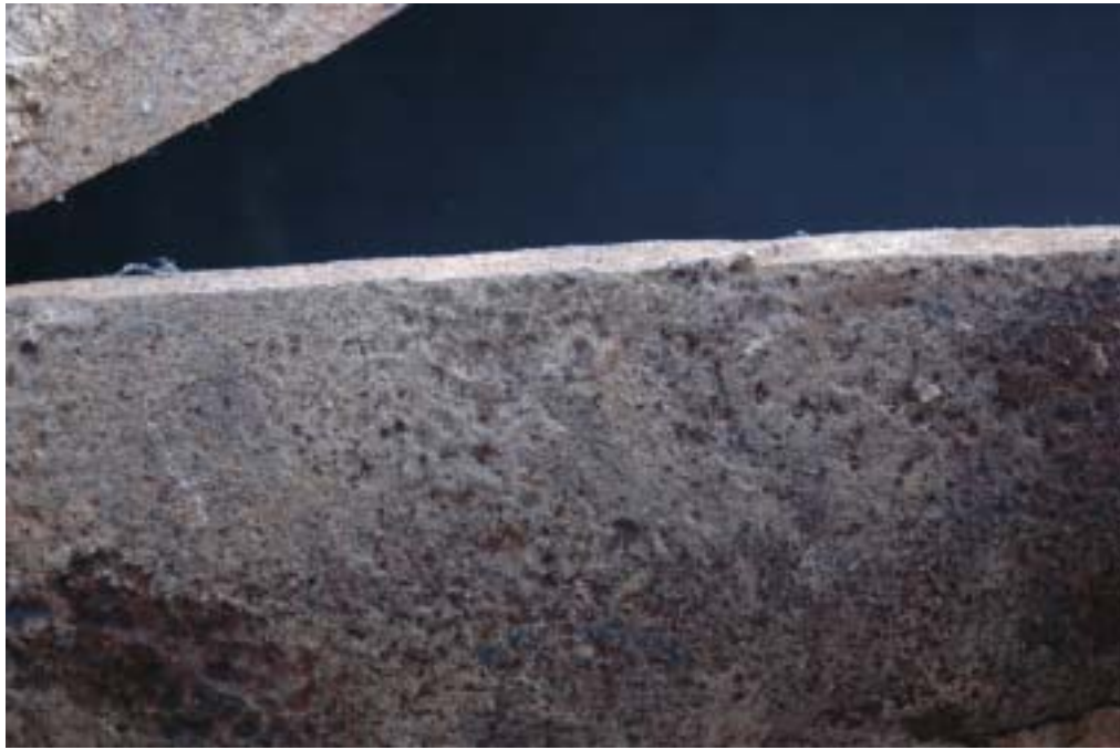
写真 3 容器の外面腐食の状況
