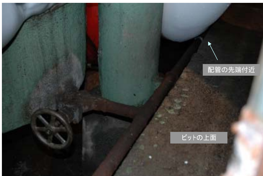
写真2 ドレン配管の先端
