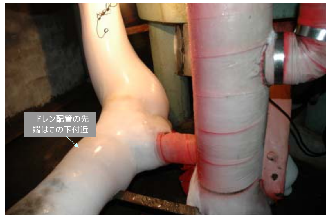
写真3 ドレン配管の先端付近
