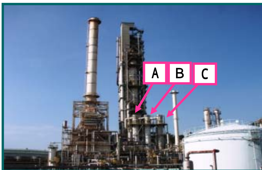
写真 3 縦型熱交換器の設置状況(A号機で発災)
