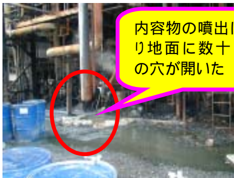
写真1 安全弁放出管(A)出口付近
