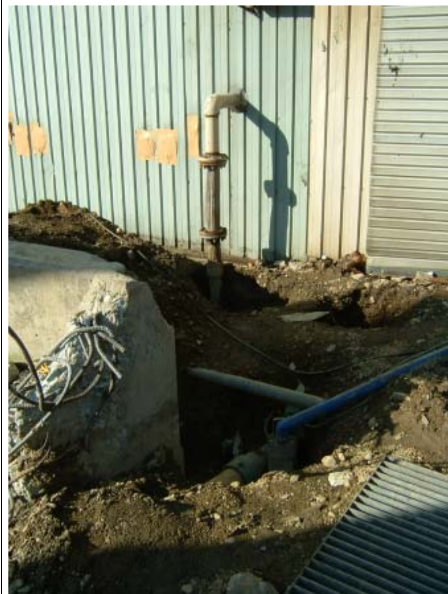
写真2 埋設管の状況
