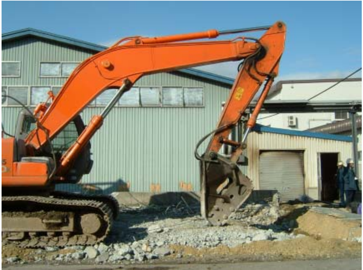
写真3 基礎の解体に使っていたコンクリート破砕機
