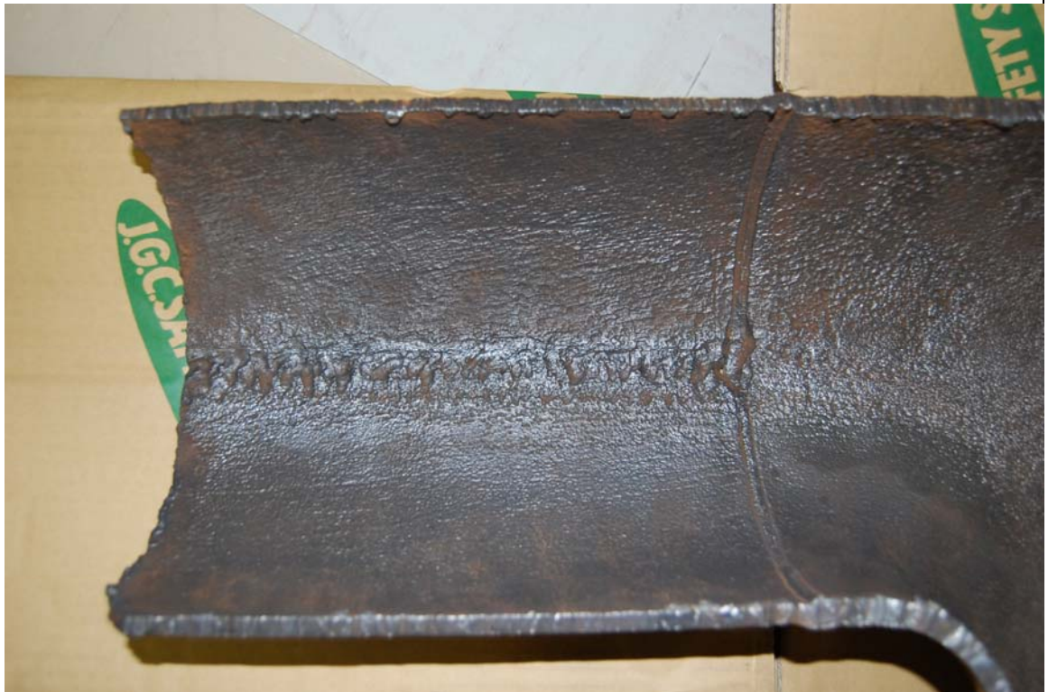
写真 4 帯状腐食の状況
