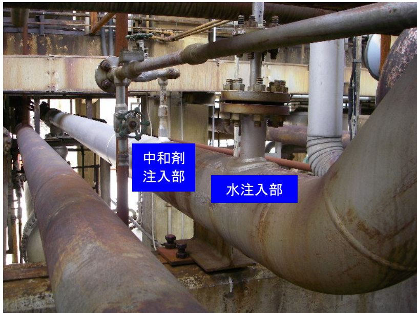
写真2 復旧後の配管
