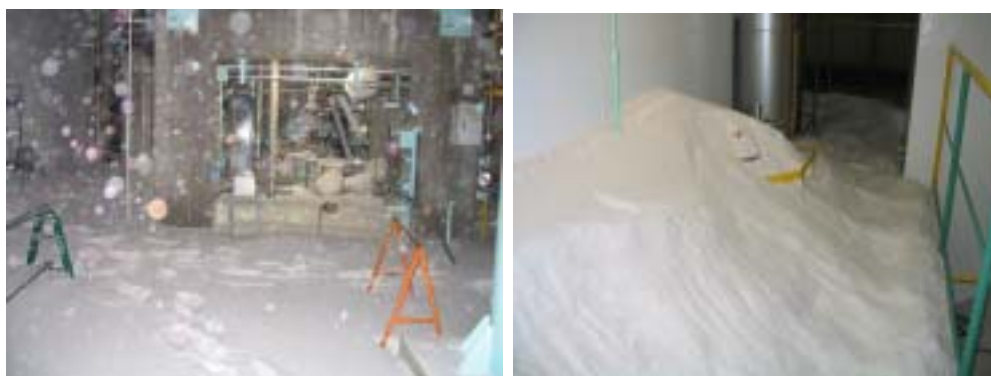
写真4 パーライトの流出状況
