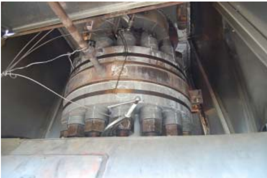
写真 3 下から見上げた状況(現状)
