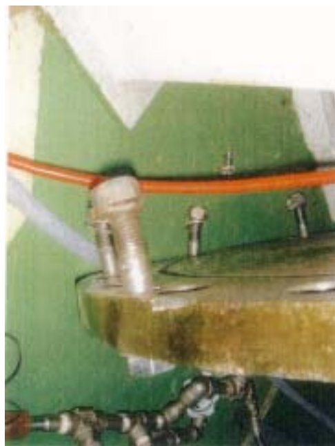
写真5 ボルトとフタ板の状況
