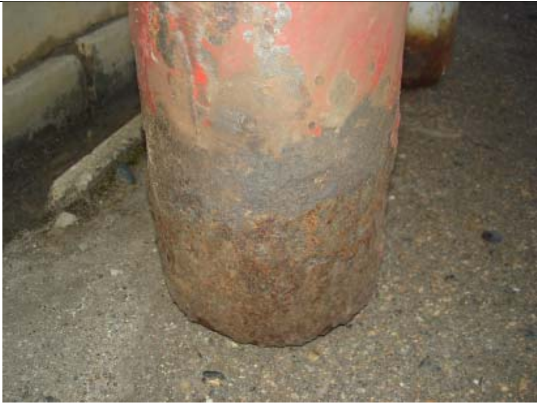
写真6 水素容器の腐食状況
