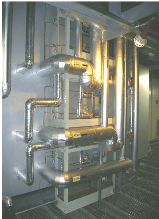
写真 6 事故防止対策処置後の設備外観
