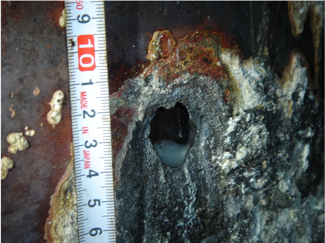
写真1 開口部の状況
