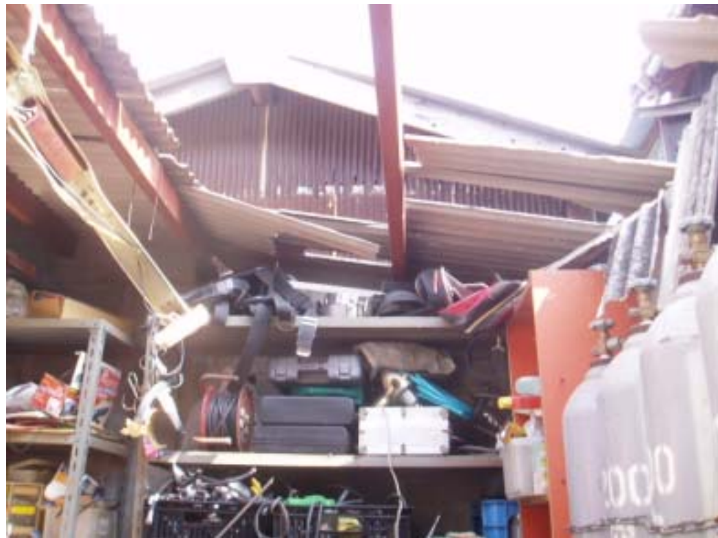
写真4 充てん所内部の状況
