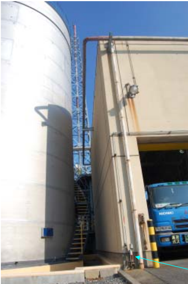
写真 3 ベントスタックと塩素室外壁のガス検知器(19:15 塩素ガスを検知)
