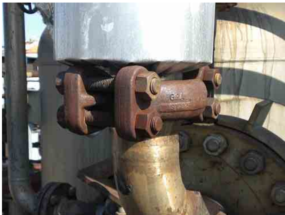
写真2 締結状態のグレイロック継手
