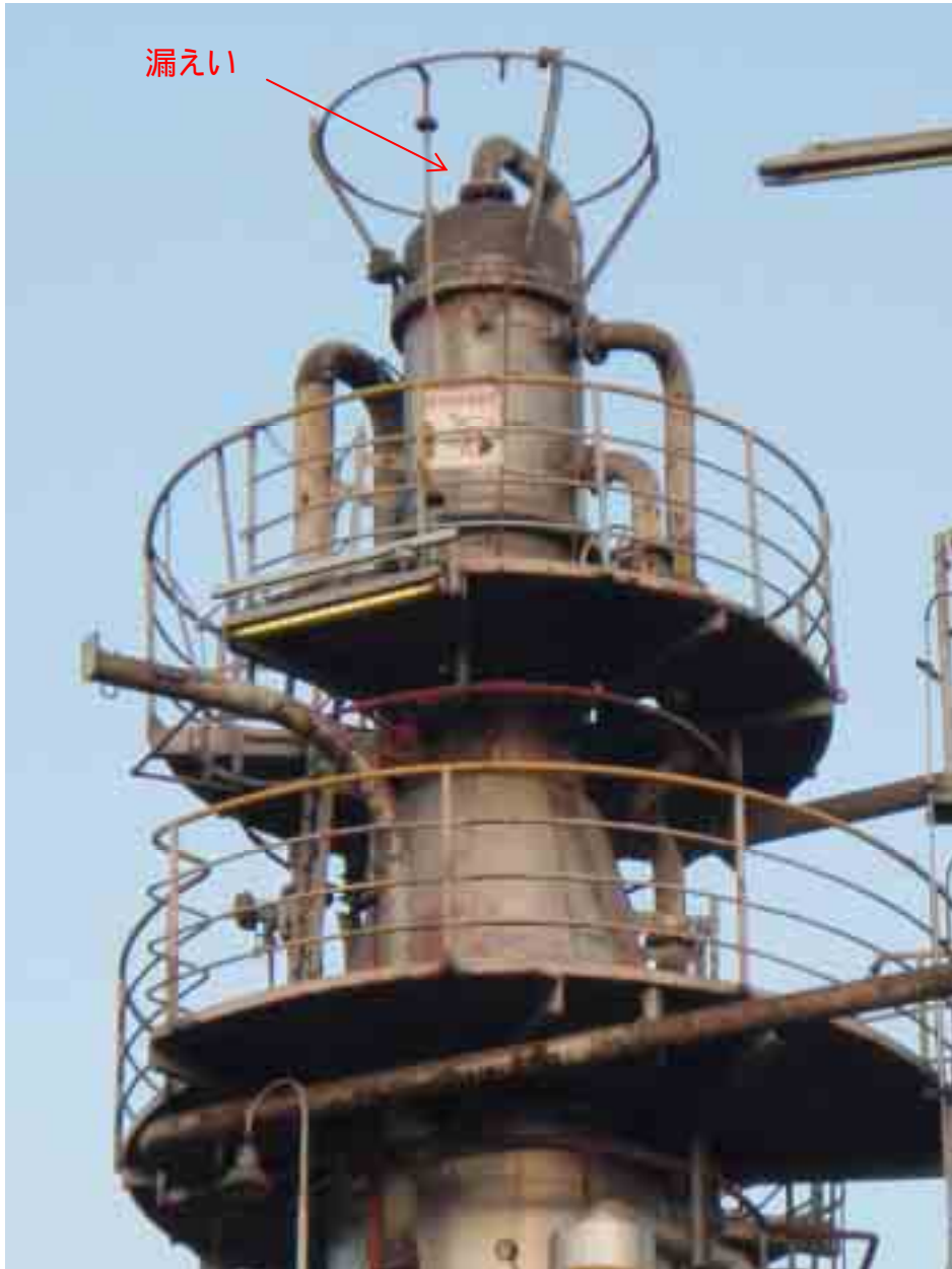
写真1 分解塔の塔頂部
