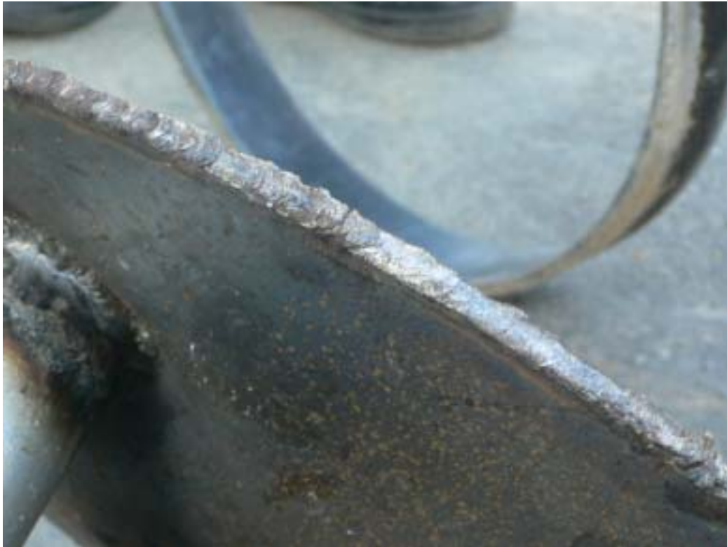
写真4 閉止板の溶接部
