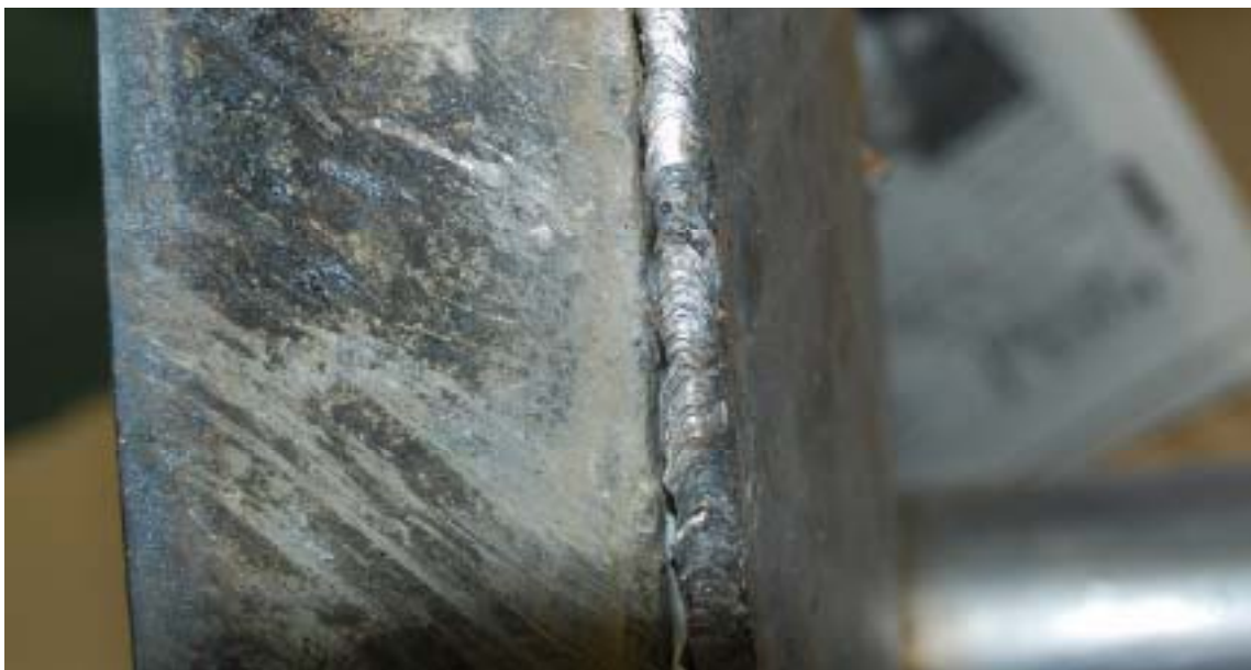
写真5 導管(短くカット)とふた板を合わせた状況
