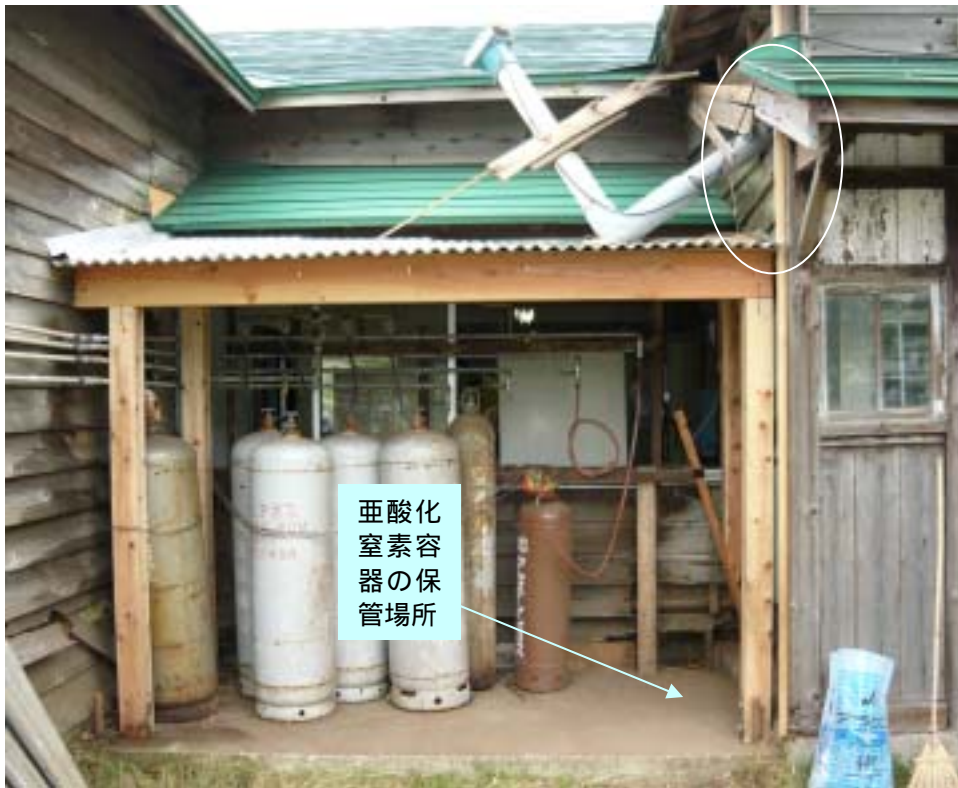
写真1 容器置場の状況
