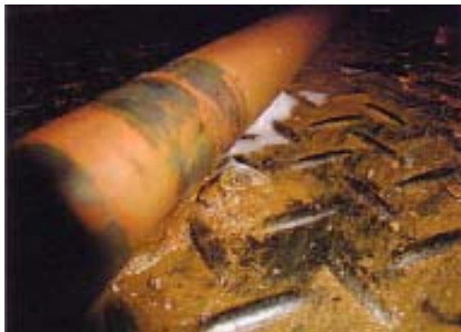
写真 9 配管固定箇所 (固定金具等は取り外し後)
