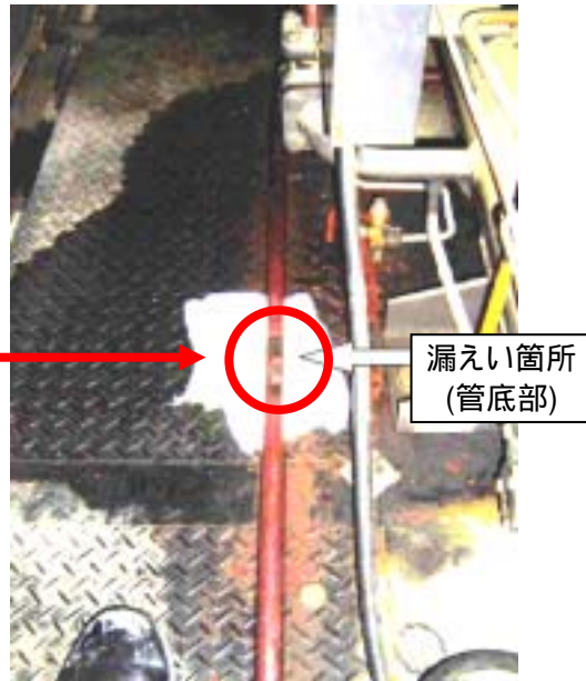
写真 8 漏えい箇所付近外観
