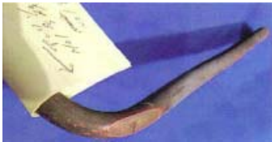
写真2 均圧配管表面
