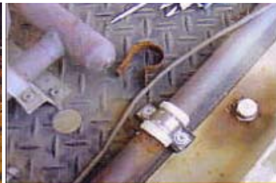
写真 10 以前の固定金具及び修理後 (漏えい箇所とは別の箇所)
