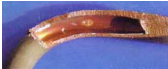
写真3 均圧配管内面
