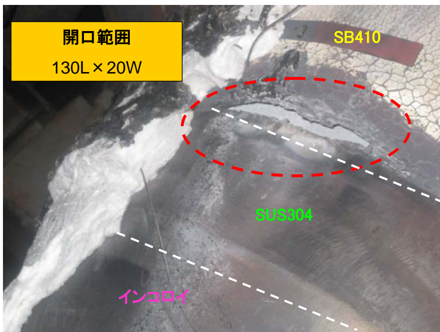
写真1 破断部の状況
