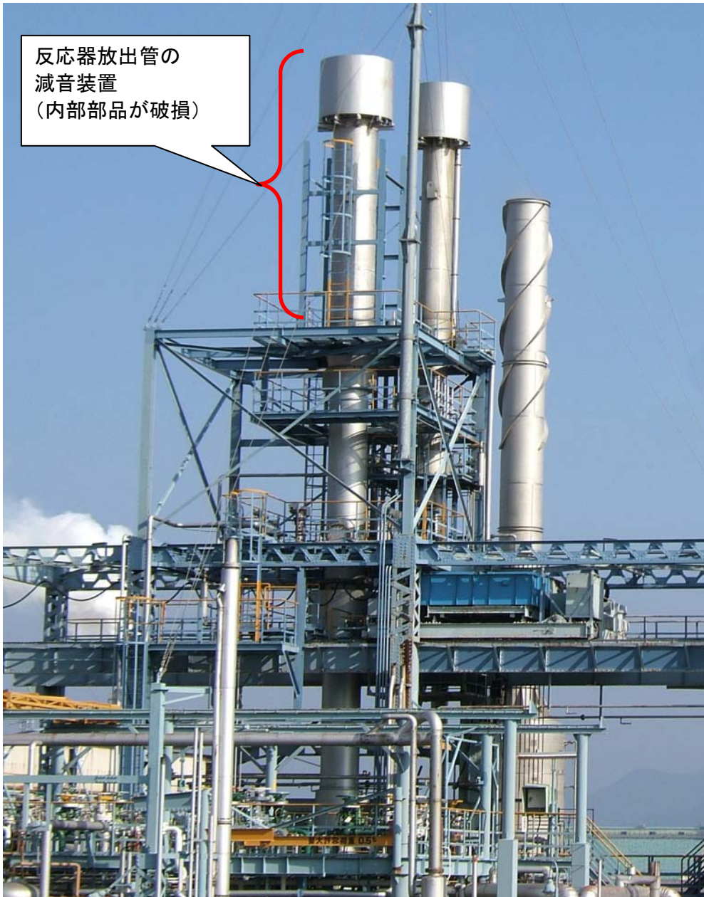
写真 1 減音装置の取り付け状況
