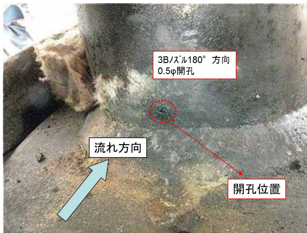
写真 1 開口部の状況 (外面側)
