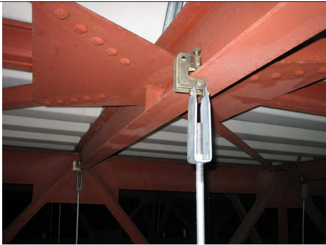
写真 4 吊り金具の状況( )
