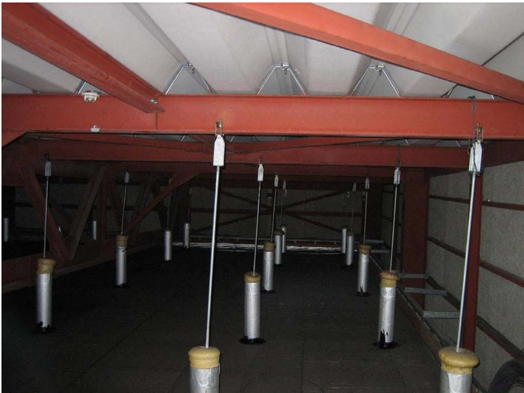
写真 5 中天井のつり下げ状況(鉄ワイヤーで仮補強)
