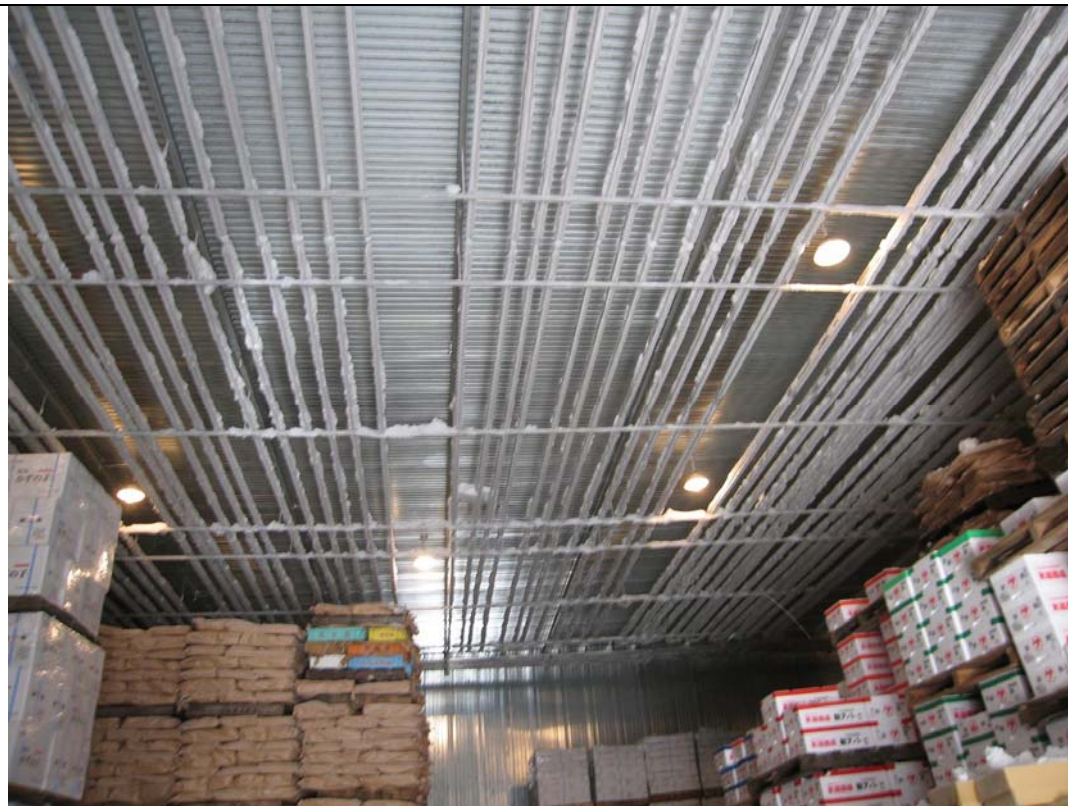
写真 6 冷却コイルの設置状況(冷却コイルは吊ったアングル材の上に乗っている)
