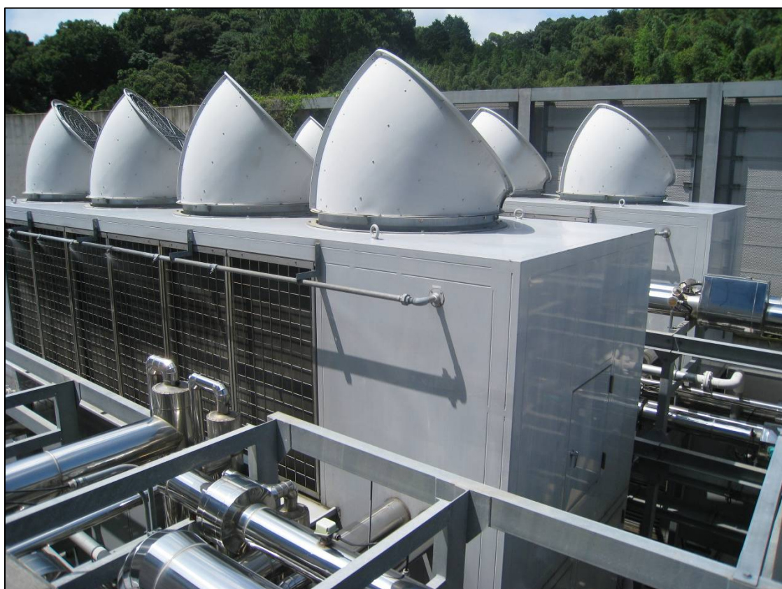
写真 1 機器の設置状況
