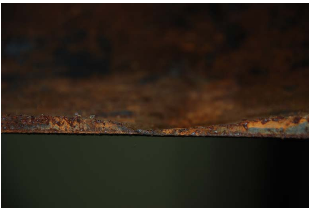
写真5 胴板の断面状況
