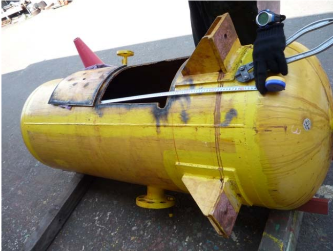
写真1 クッションタンクの開口部の切断状況(その1)
