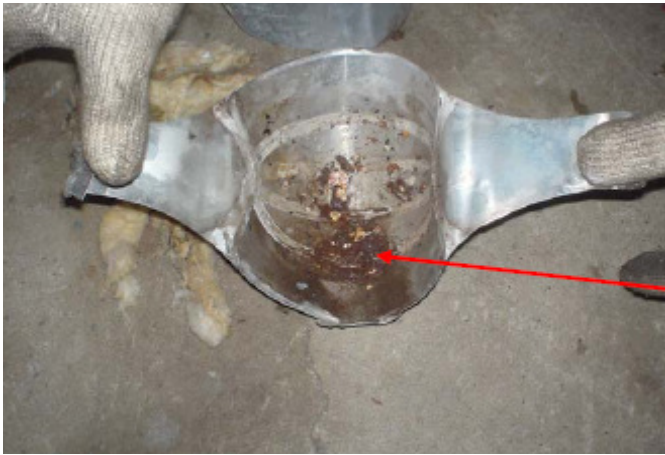
写真6 外装内面の状況
