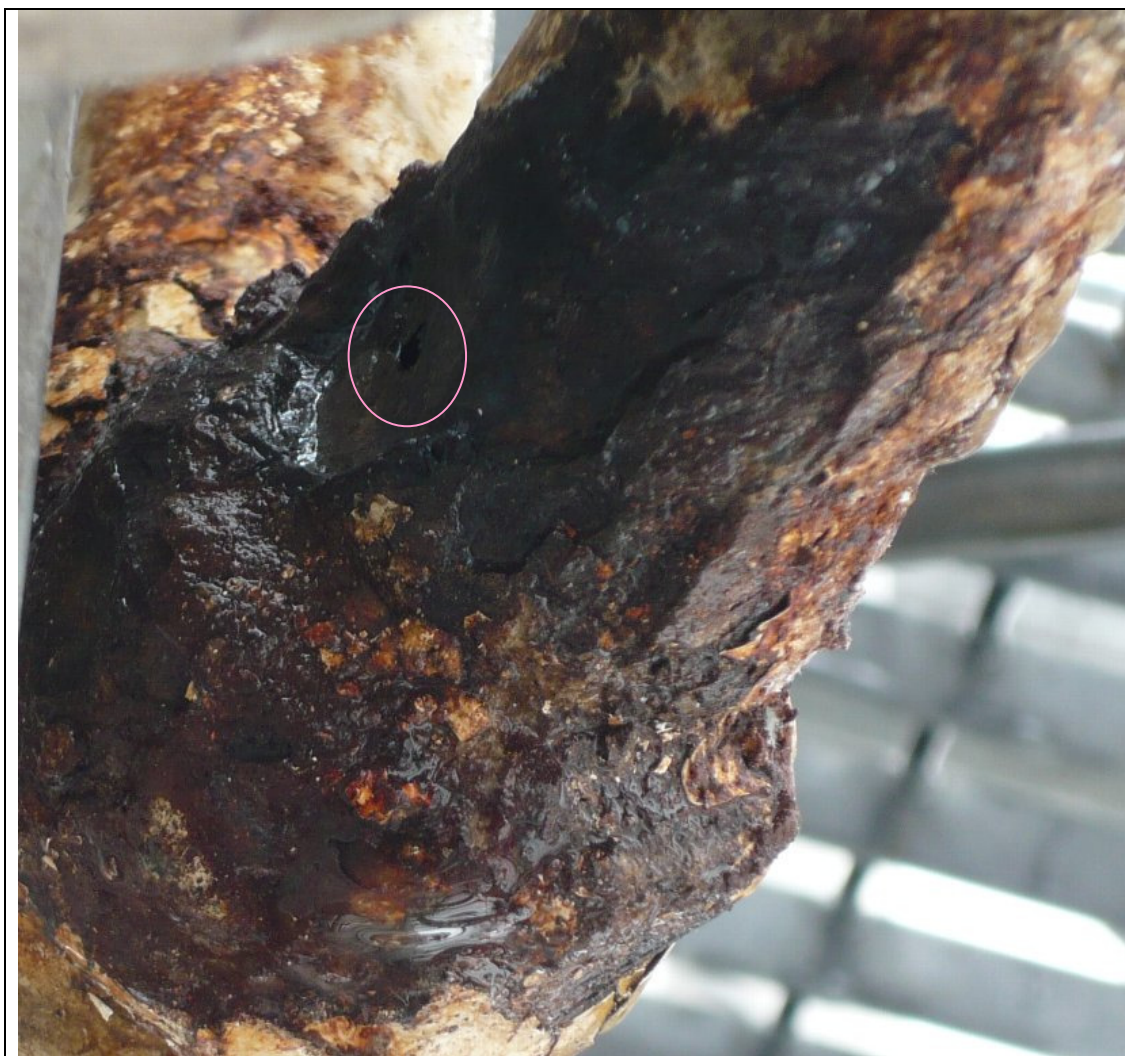
写真1 開口部の状況
