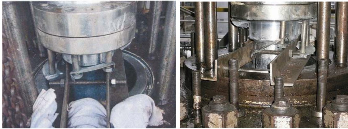
写真 2 攪拌機取り出し状況
