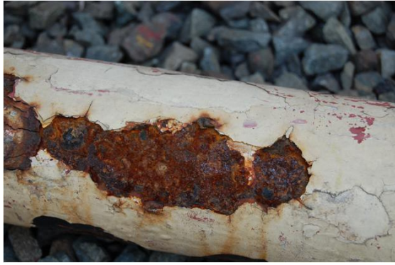
図3 配管表面状態
