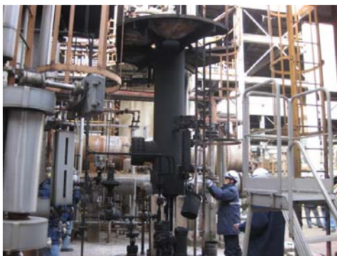
写真 1 現場の状況(その 1)
