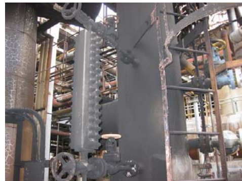
写真 2 現場の状況(その 2)
