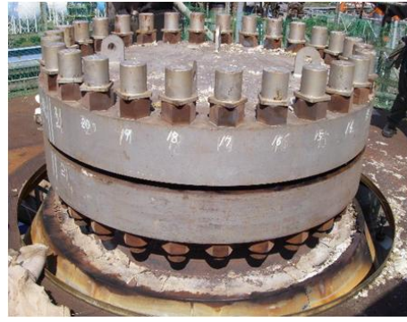
写真4 フランジ保温材取外し(南側)
