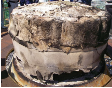
写真3 フランジ保温外装取外し(南側)
