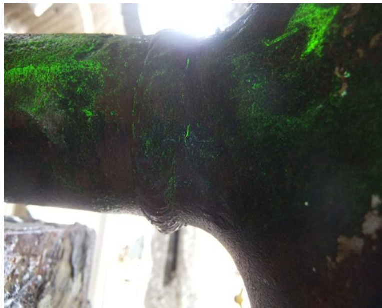
写真 2 連通管下部に発生した溶接線近傍の割れの状況
