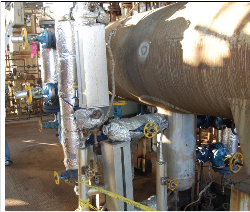
写真 7 連通管の状況(復旧後)
