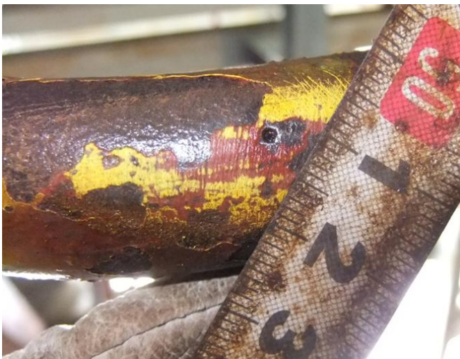
写真 2 開口部の状況
