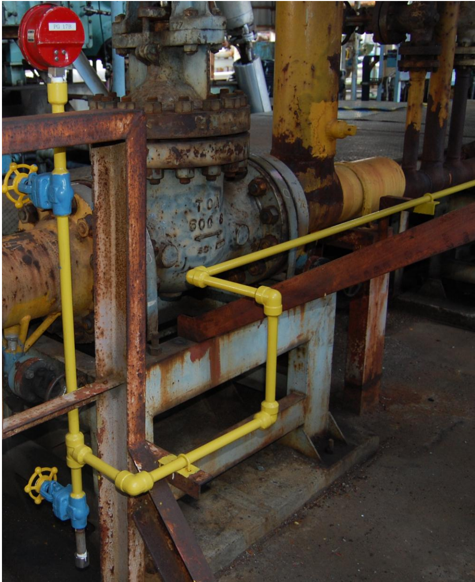
写真 3 圧力計導圧管の更新後の状況
