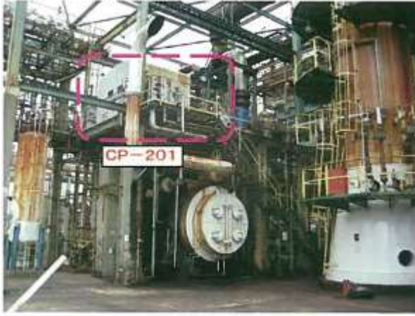
CP-201設置状況(南東側から)
