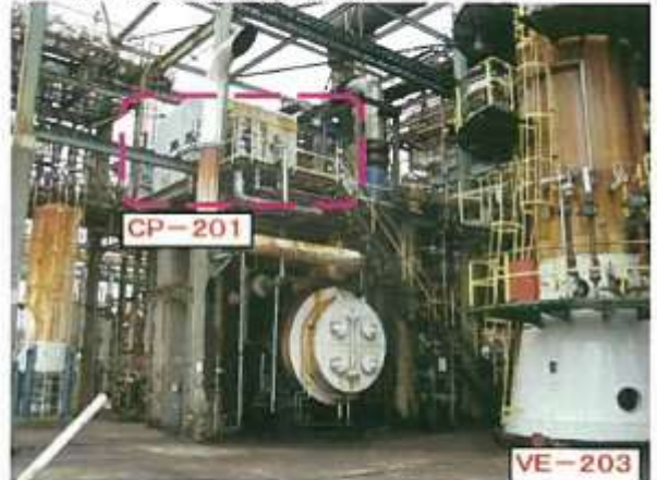
CP-201設置状況(南東側から)
