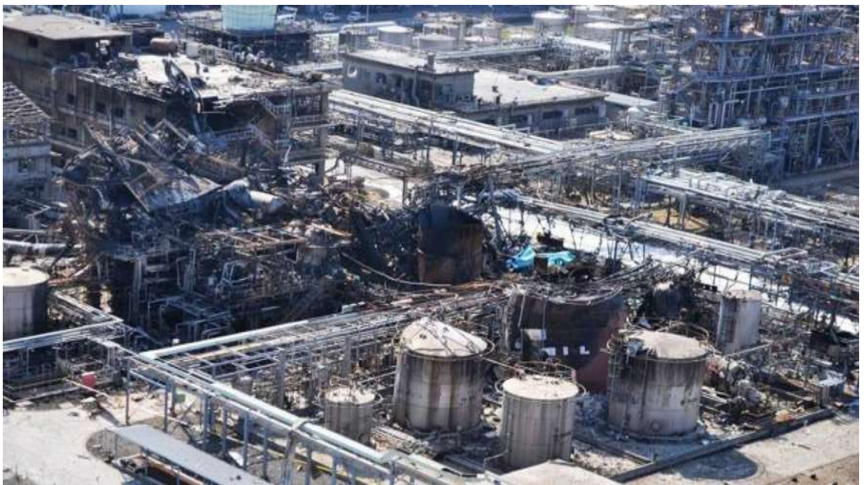
写真-1 被災状況
