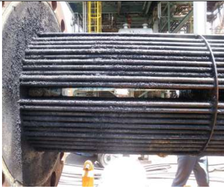
写真2 チューブバンドルの状況
