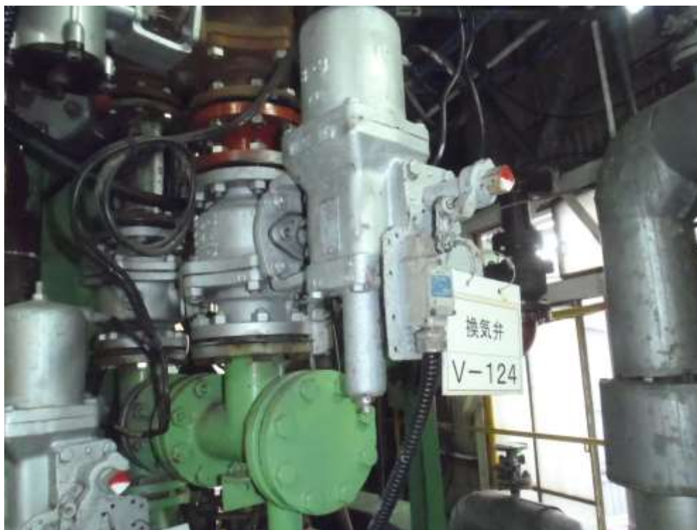
写真1 閉め忘れたバルブ(V-124)
