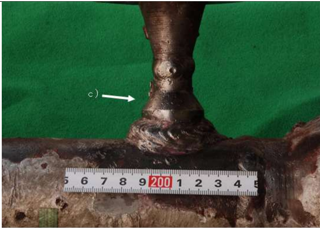
写真-2 配管の外観状況(調査のため塗料の剥ぎ取りを実施)
