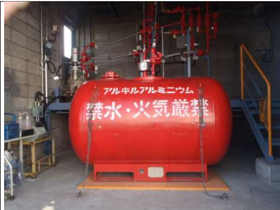
写真 1 アルキルアルミニコンテナの設置状況
