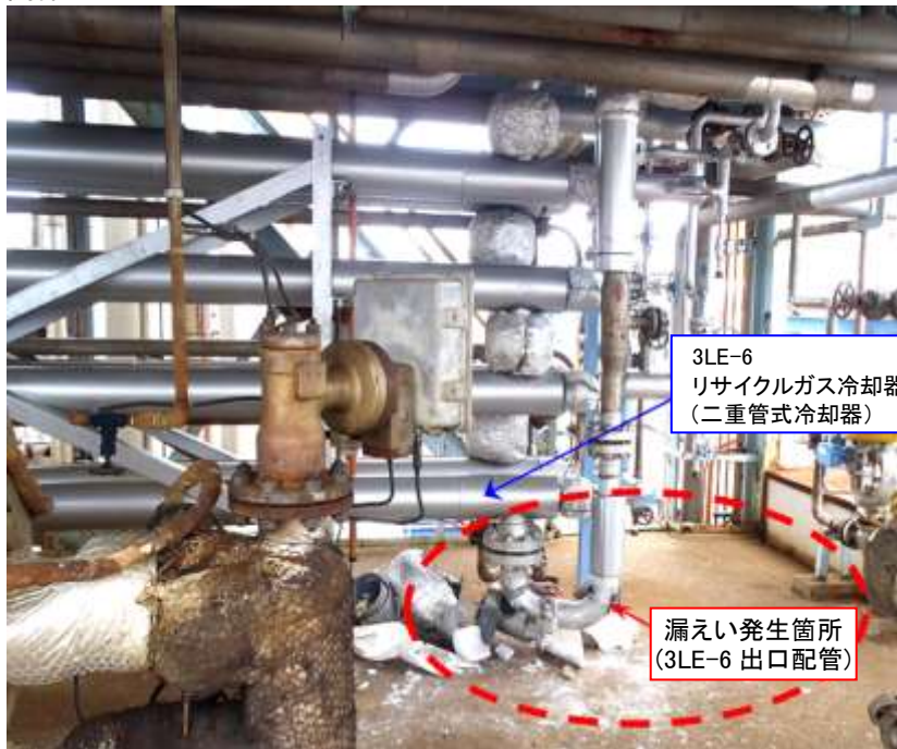
写真1 熱交換器出口配管の状況
