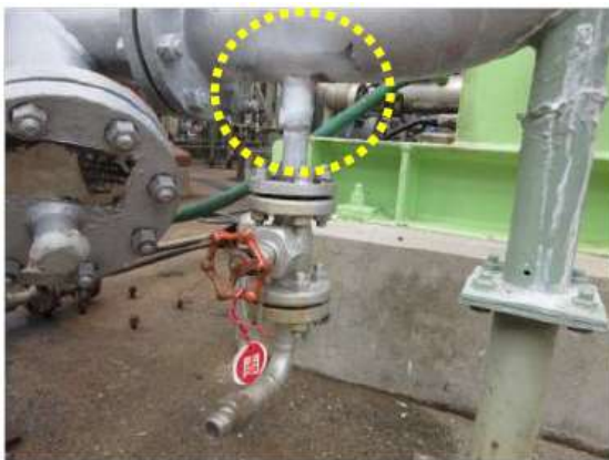
写真 1 ドレンノズルの状況
