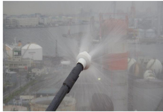
図 4 散水ノズルの散水状況(左:補修前、右:補修後)
