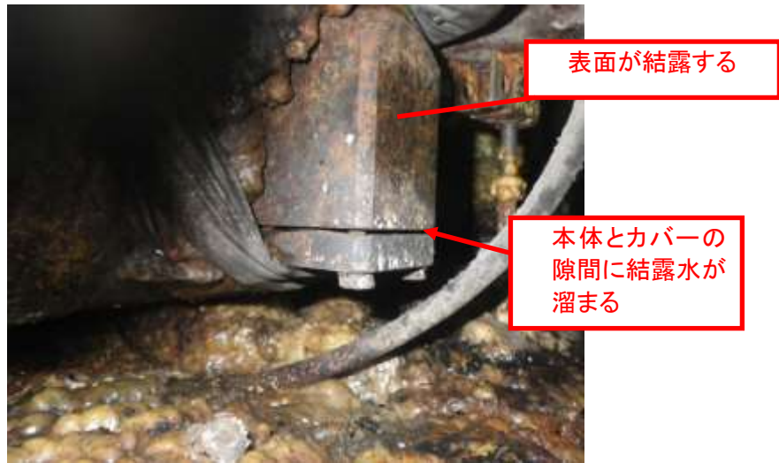
図6 ストレーナー設置状況
