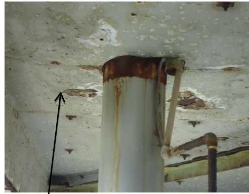
写真3 床下側からの外観 (事故当時)
