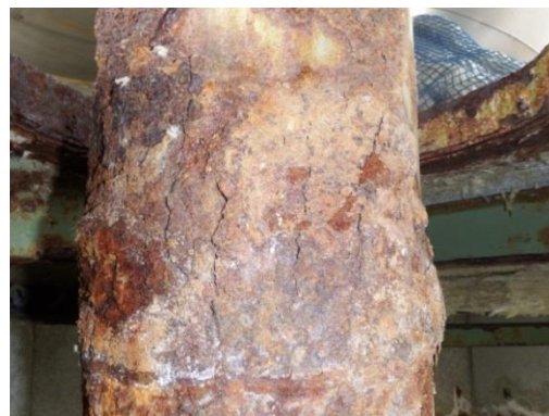
写真5 床下側からの外観 (防音施工取外し後)
