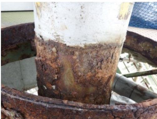
写真4 床上側からの外観 (防音施工取外し後)
