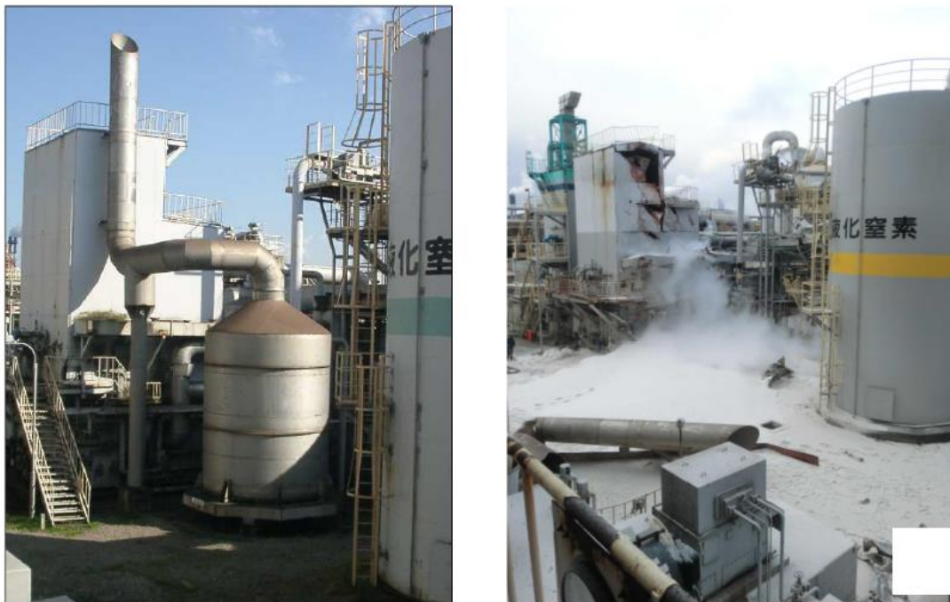
写真1 No. 3放液溜飛散状況
