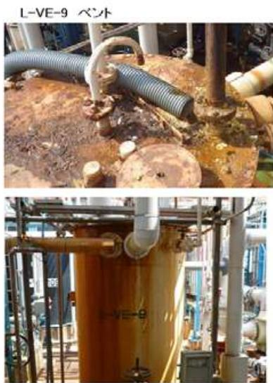
図3 温水貯槽のベント(写真上) 温水貯槽外観
