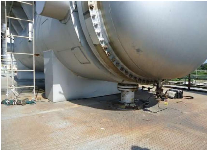
写真1 凝縮器と降液配管
