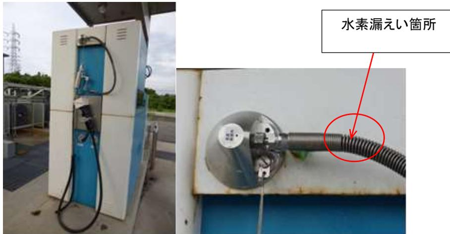
写真1 ディスペンサーと水素漏えい箇所
