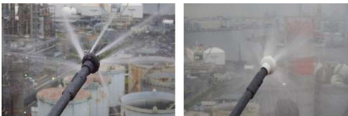
図4 散水ノズルの散水状況(左:補修前、右:補修後)
