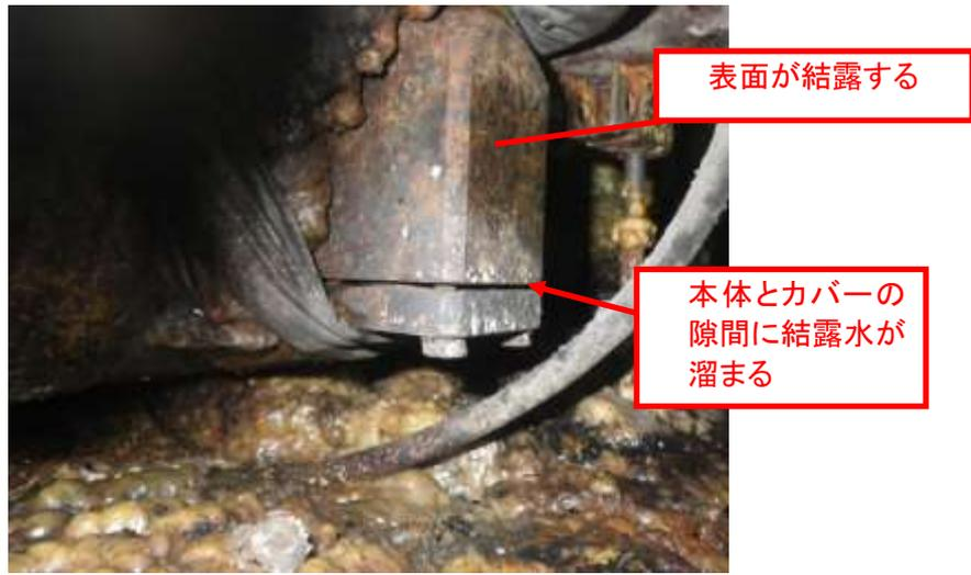
図6 ストレーナー設置状況
