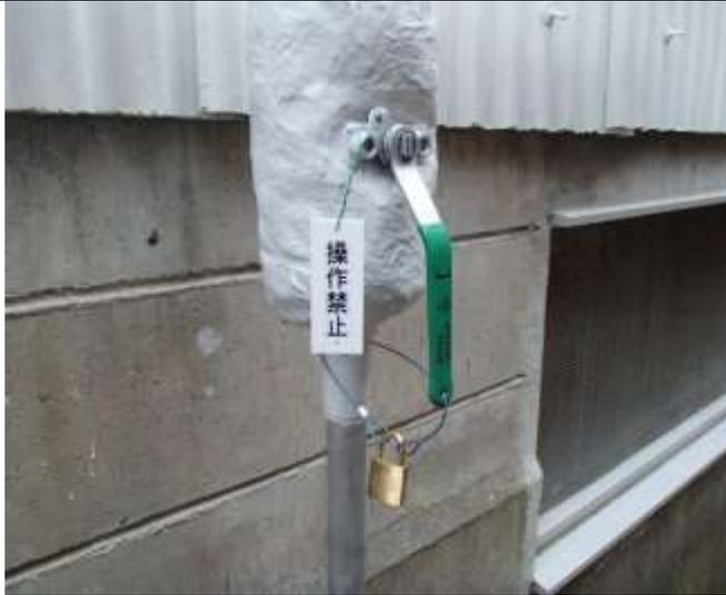
写真2 ベント配管放出元弁の施錠と操作禁止札
