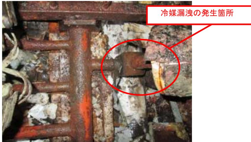
図1 電子式膨張弁用ストレーナー周辺
