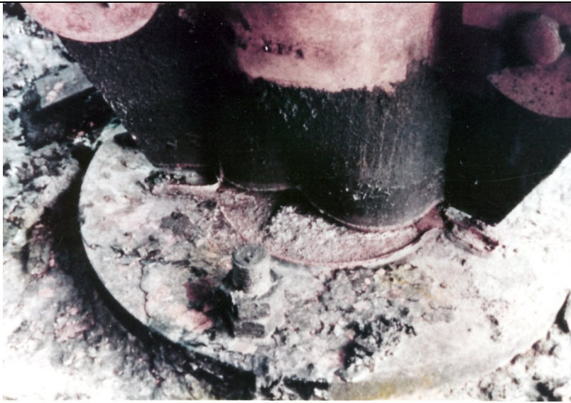
写真 10 ベースプレートと支柱の状況
