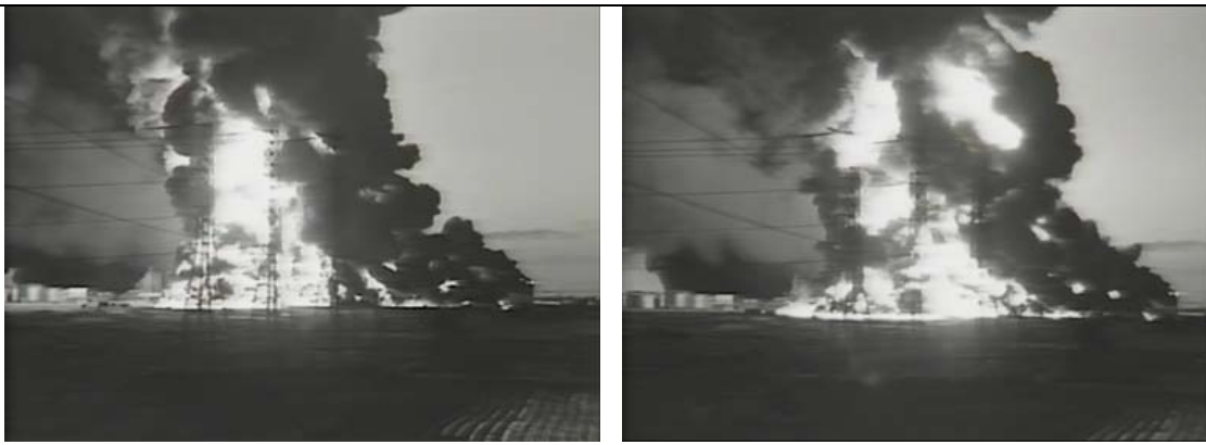
写真4 地震当日夜9時頃 4.5万キロリットル原油タンクの側板くずれ込み、フラッシュオーバーで原油が燃えながら拡散している状況(左→右)(*2)
