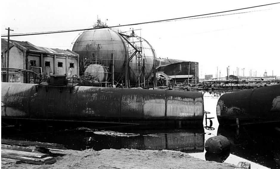
写真 13 LP ガス球形貯槽周辺の惨状
