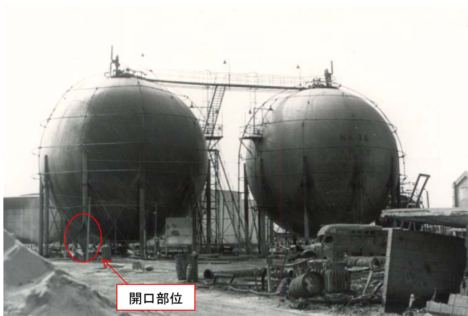
写真 6 被災した 1,200m 3 LP ガス球形貯槽(左#85、右#84)
