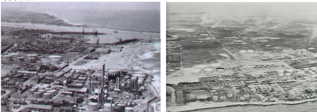
写真 1 左:建設当時の旧工場(製油所のカタログより引用)、 右:新工場建設後の製油所(*2 LP ガス球形貯槽は確認できない)
