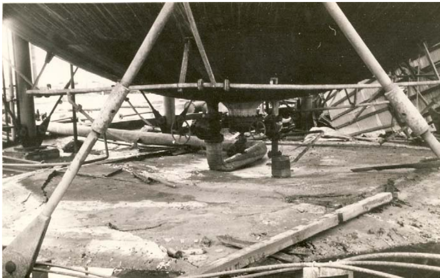
写真 11 LP ガス球形貯槽の下部配管の状況
