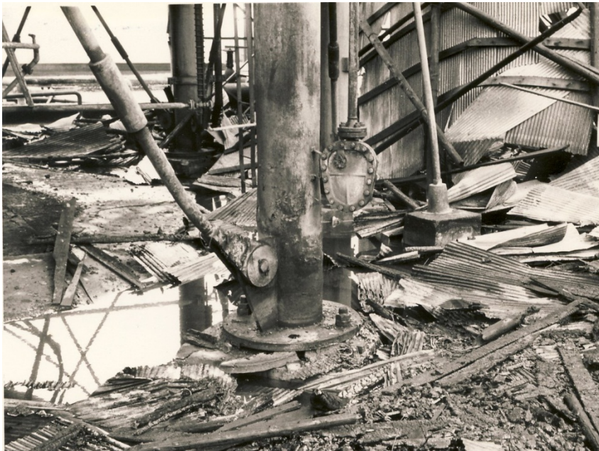
写真 9 LP ガス球形貯槽の支柱(坐屈発生)と液面計指示部
