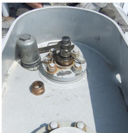
写真1 スリップチューブ式液面計の例 図2 スリップチューブ式液面計の概要
