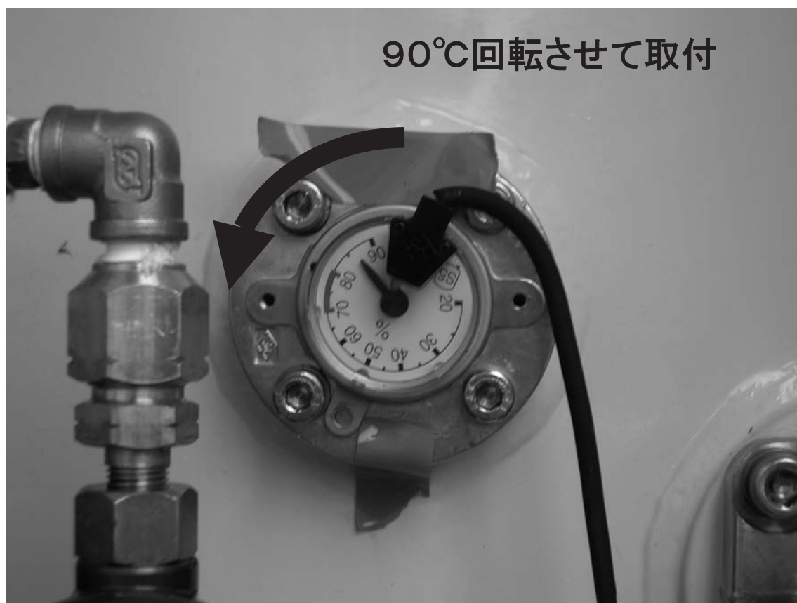
液面計取付状況
