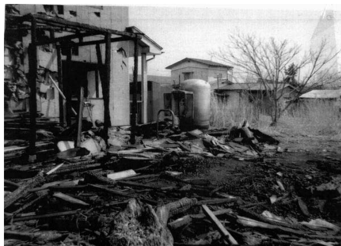
火災発生現場
