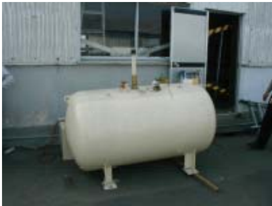
バルク貯槽 (事故時に設置していたもの)
