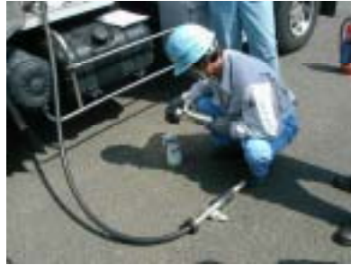
交換した安全継手 (事故時のものと同型)
