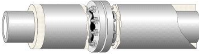
フランジ部 (外装材端部から雨水浸入)
